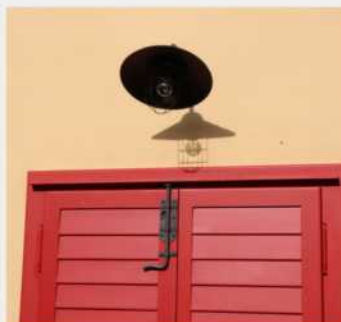
Obnova oken a výroba nových dveřnic včetně kování.
